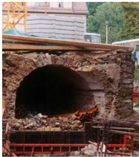
Mittelalterlicher Wohnturm (Breite Str.)
